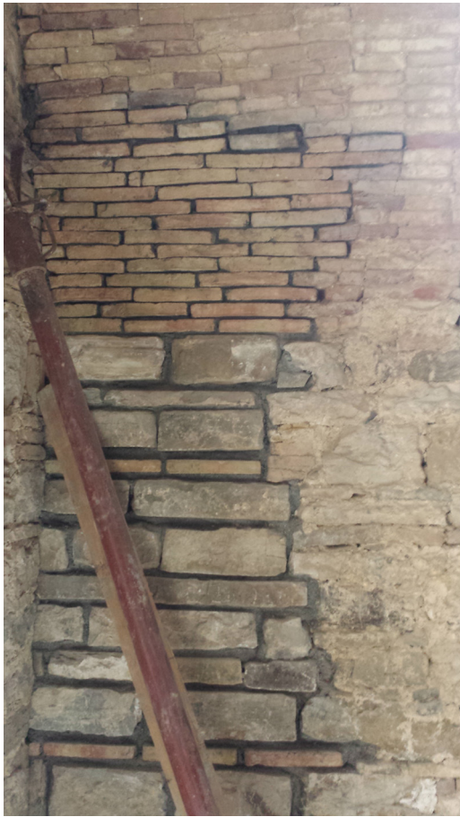
Ripristino muratura in pietrame dopo aver incassato la tubazione
