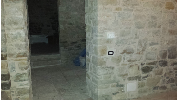
Ripristino muratura a seguito posa in opera di prese incassate
