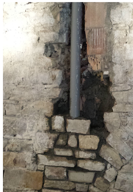
Ripristino muratura in pietrame
