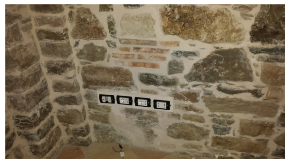
Ripristino muratura a seguito posa in opera di prese incassate
