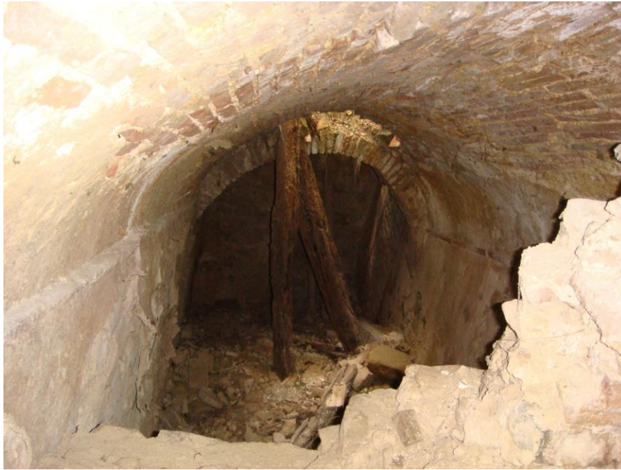
11. Interno vano nord-est
