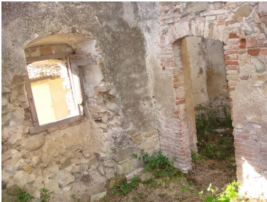
16. Porta di comunicazione tra il vano ovest e il vano est del secondo livello
