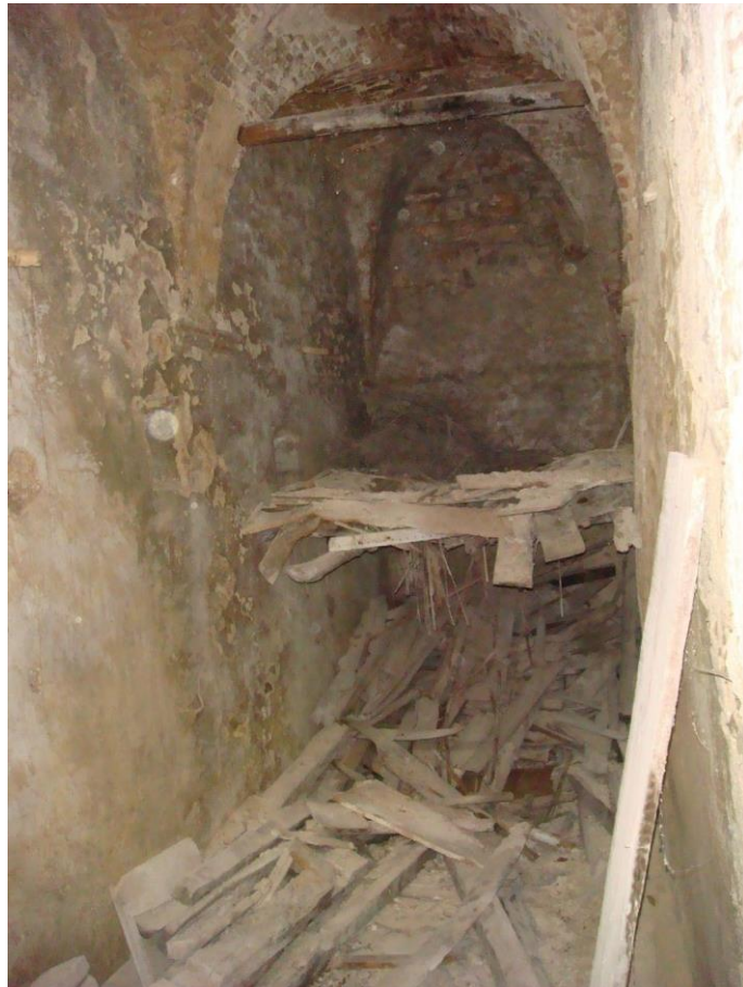
4. Interno vano sud-ovest primo livello
