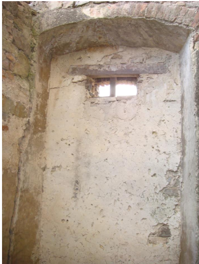
18. Interno vano est secondo livello lato nord
