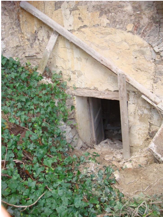
2. Porta di accesso al primo livello del vano ovest
