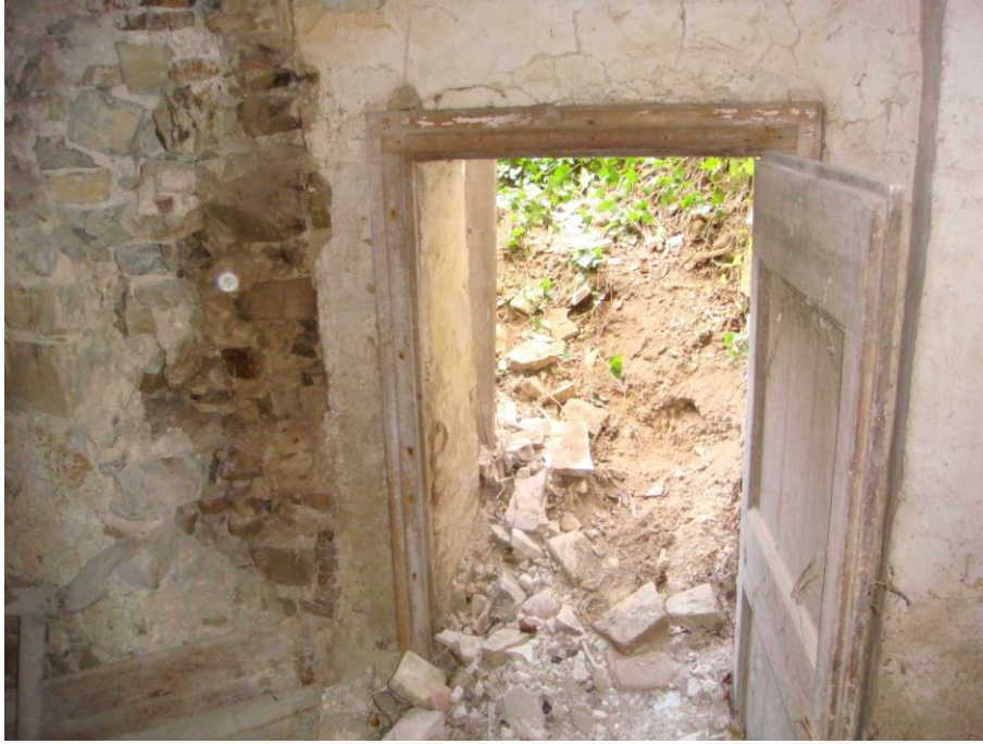
3. Porta di accesso al primo livello del vano ovest vista dall'interno
