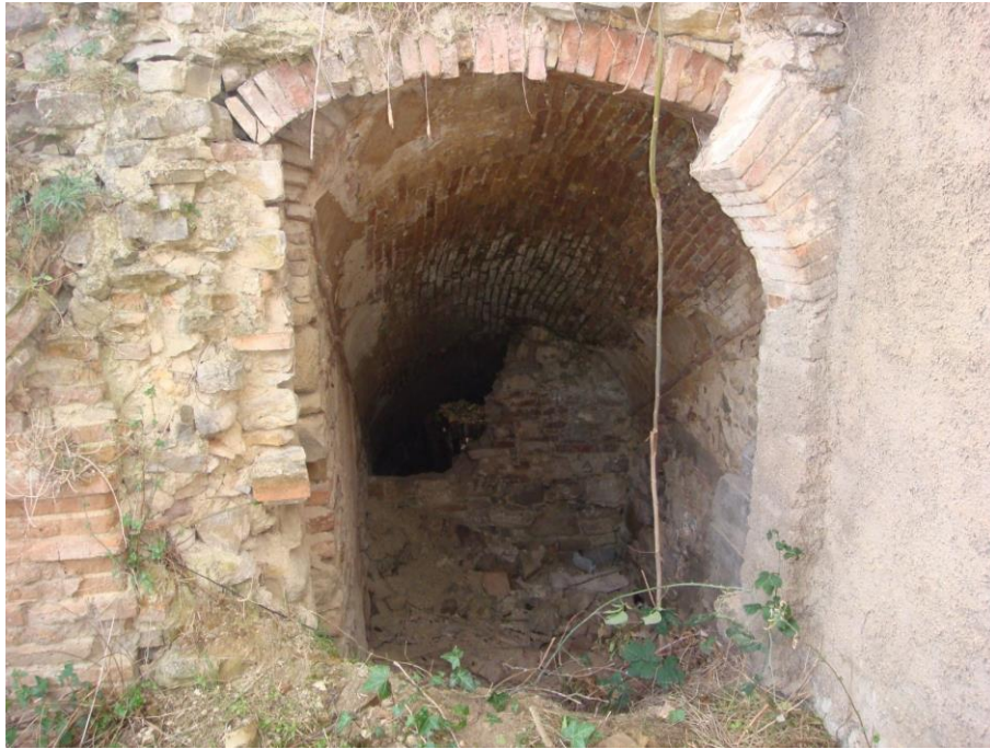
13. Prospetto vano sud-est del secondo livello
