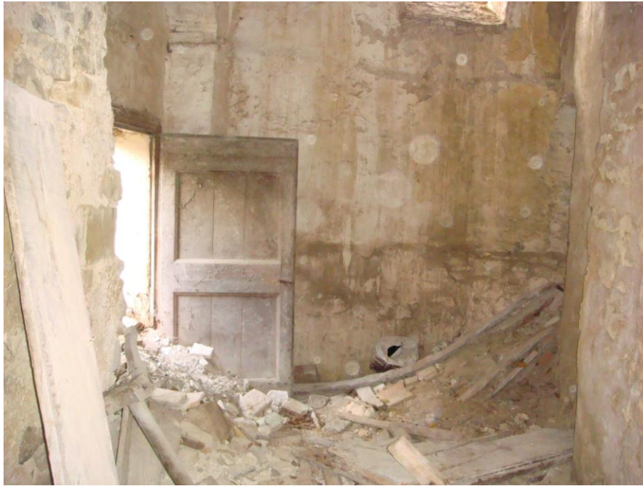
5. Interno vano nord-ovest del primo livello
