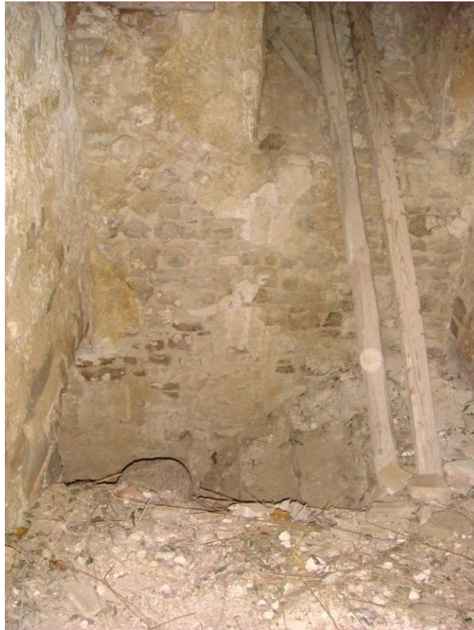
7. Interno e scala del vano nord-est del primo livello
