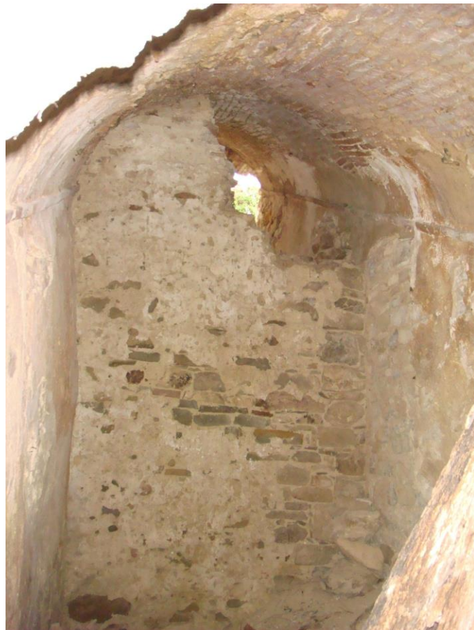
10. Interno vano nord-est lato sud del primo livello
