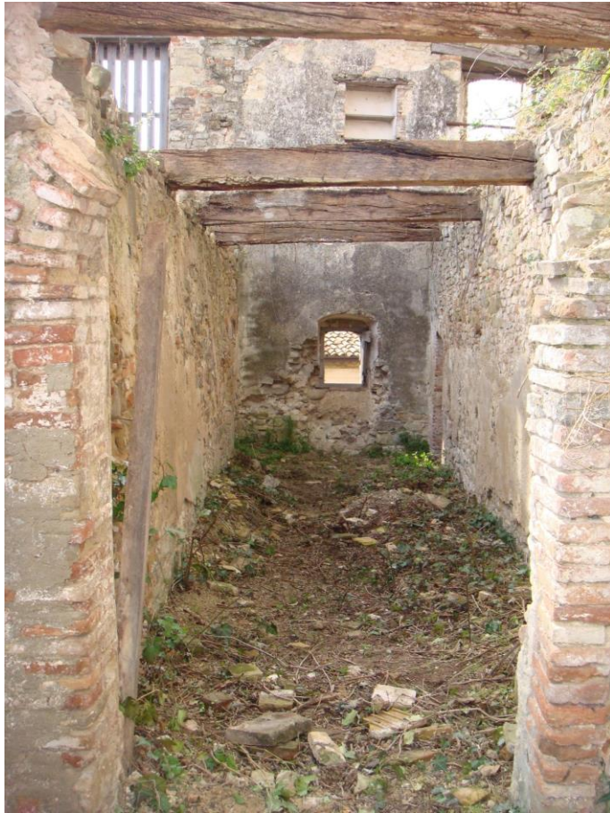
15. Interno vano ovest secondo livello
