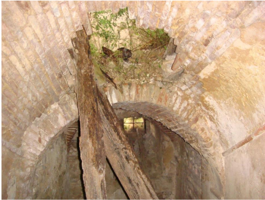
9. Interno vano nord-est del primo livello con volta in crollo
